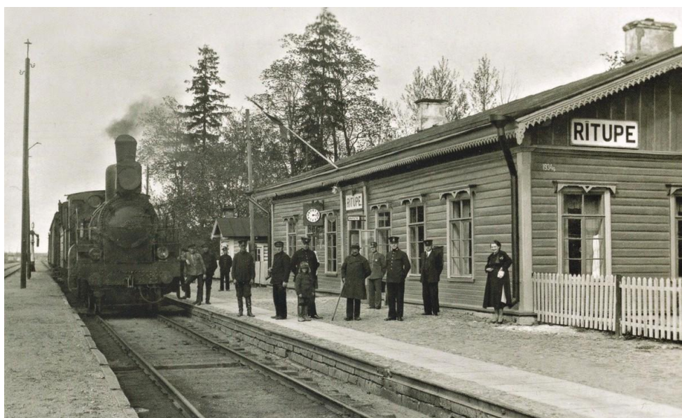
3.att. Rītupes dzelzceļa robežkontroles punkts.
